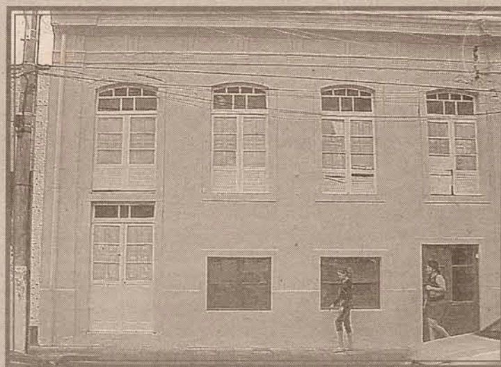
Casa de porão alto. Residência no pavimento superior e porão reservado para uso comercial ou depósito. Seu frontão simplificado, sugere que seja um acréscimo. Na Praça República Juliana.
